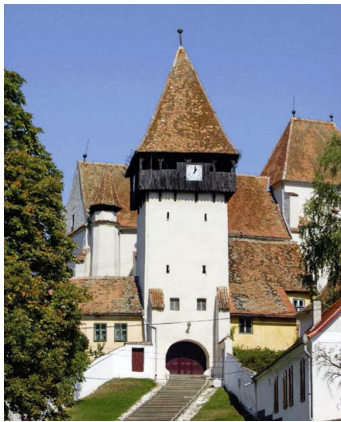
Kirchenburg in Baaßen/Bazna, Siebenbürgen (Foto: Stiftung Kirchenburgen)
